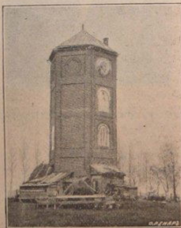
Водоподъемная башня въ Егорьевскѣ.
