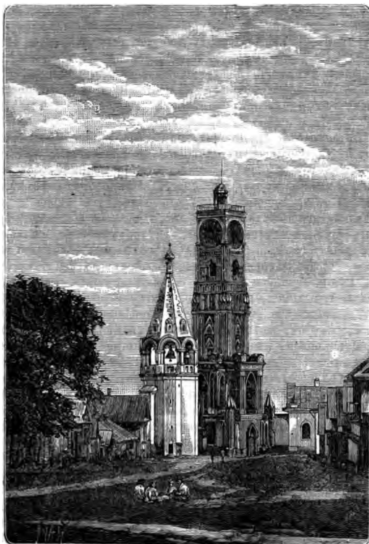
Муравьевская башня до 1882 года.
