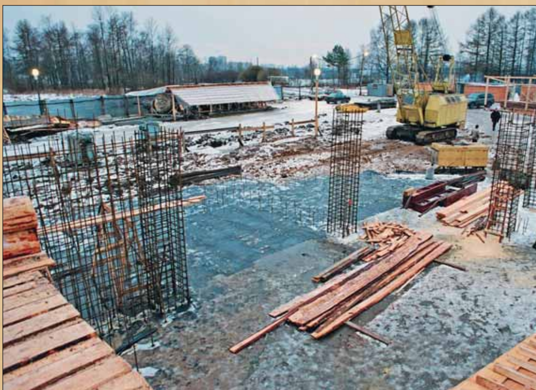
Заливка фундамента. Декабрь 2004 года
