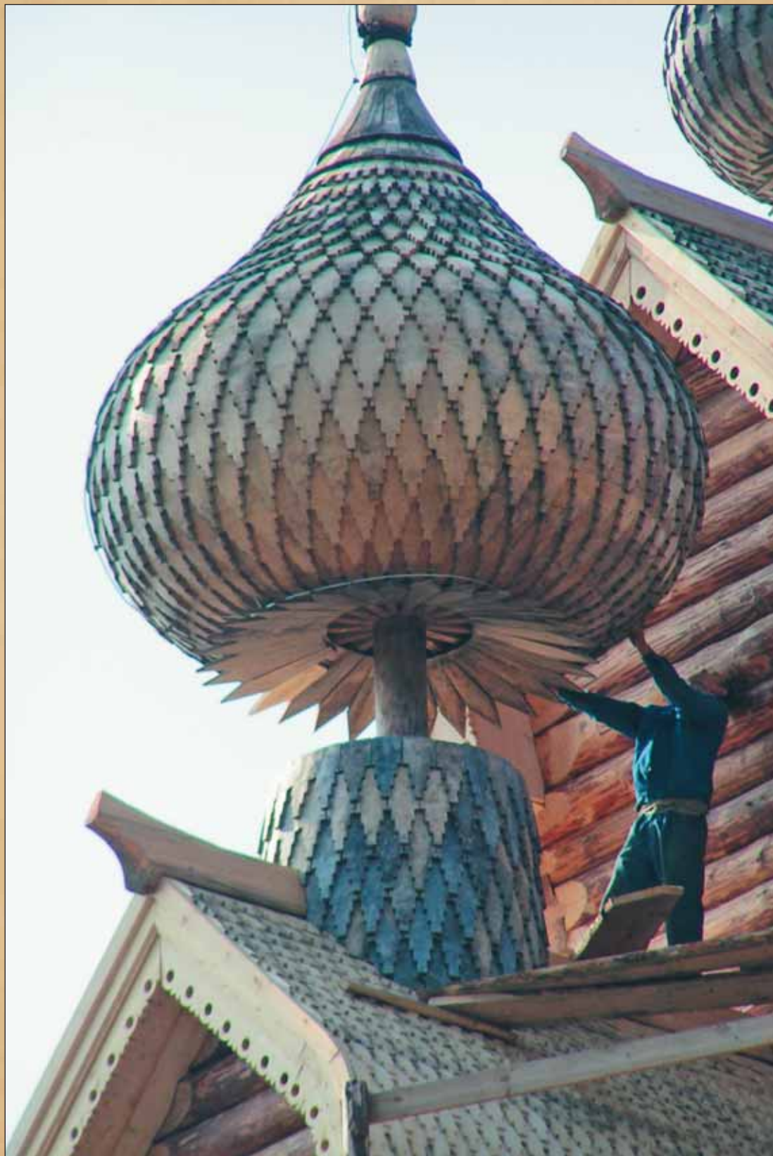
Строительно-монтажные работы: установка глав церкви. 2006 год
