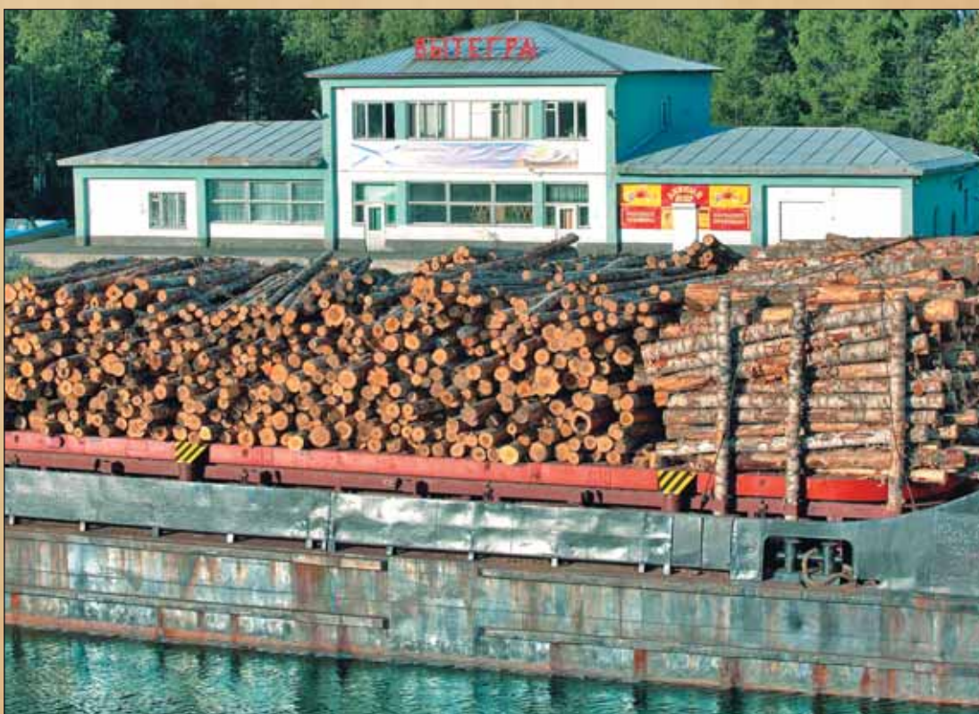
Причальные сооружения возле г. Вытегра. Лес — один из наиболее распространенных типов груза, перевозимого по Волго-Балту
