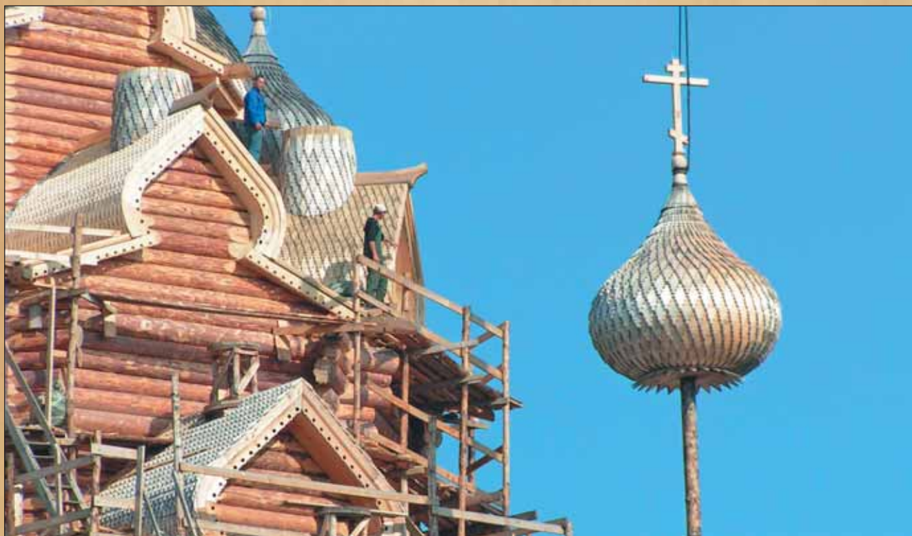
Строительно-монтажные работы: установка глав церкви. 2006 год
